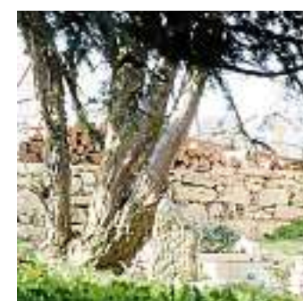
Die restaurierte Friedhofsmauer in Meura.
