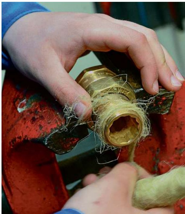
Ein Messingrohr wird an der Verbindungsstelle mit Hanf abgedichtet (Foto links). Die Steuerung einer Gastherme überprüft er mit einem Messgerät. (Mitte). Das Rohr ist zu lang (rechts).
