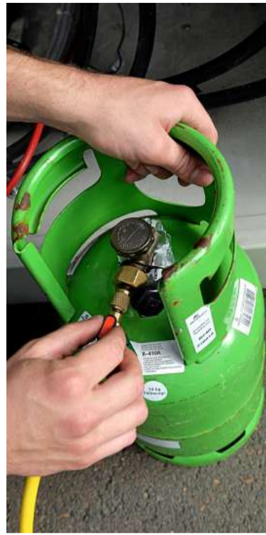
Kühlmittel wird aufgefüllt.
