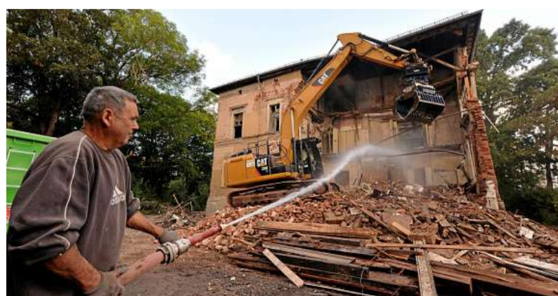
Die Biermann-Villa in der Leibnizstraße 1 in Untermhaus wird derzeit von der Firma HTS aus Schmölln abgerissen. FOTO: PETER MICHAELIS
