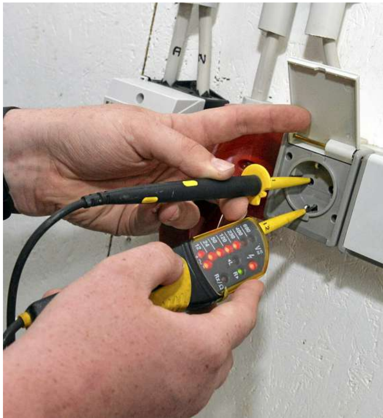
An einer Steckdose wird die Spannung geprüft.
