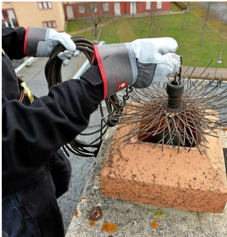
Auf einem Dach in Ronneburg. Der Schornsteinbesen wird mit einem Seil in die Esse eingelassen.
