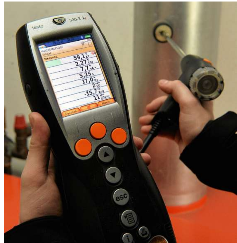
Mit einem Messgerät werden die Abgaswerte eines Gasheizkessels ermittelt.
