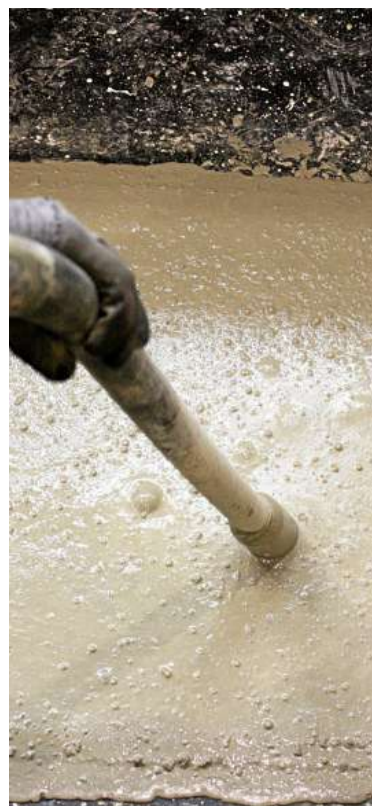
Mit einem Flaschenrüttler wird die frische Betonmasse verdichtet.
