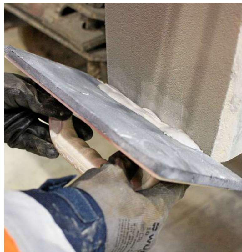
Betonkosmetik nennt sich dieser Arbeitsschritt. Mit einem Schwammbrett wird die Stelle geschlossen, an der Spannstaht abgeschnitten wurde.
